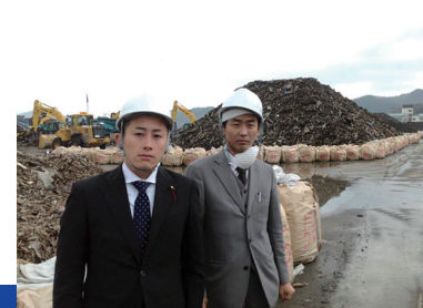
▲東日本大震災の災害ガレキを視察しました。
